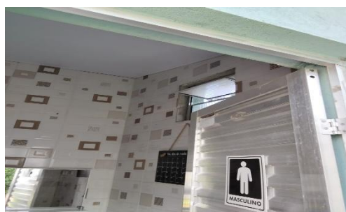
BANHEIRO SOCIAL FEMININO
