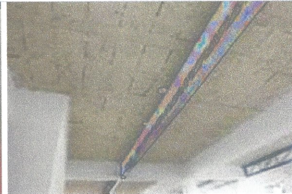
TETO DO SALÃO BANHEIRO I
