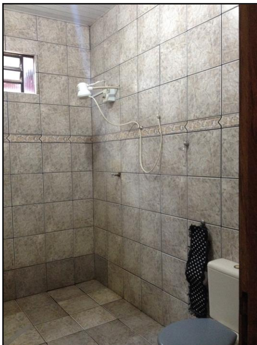
Vista interna banheiro da brinquedoteca
