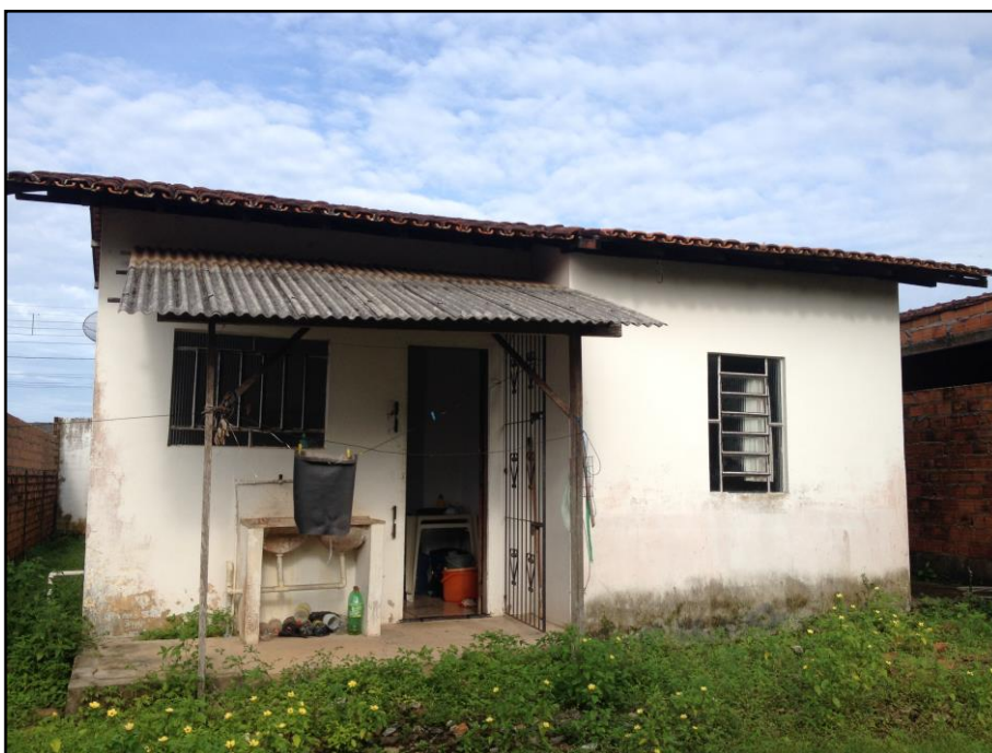
Vista Fundos da edificação
