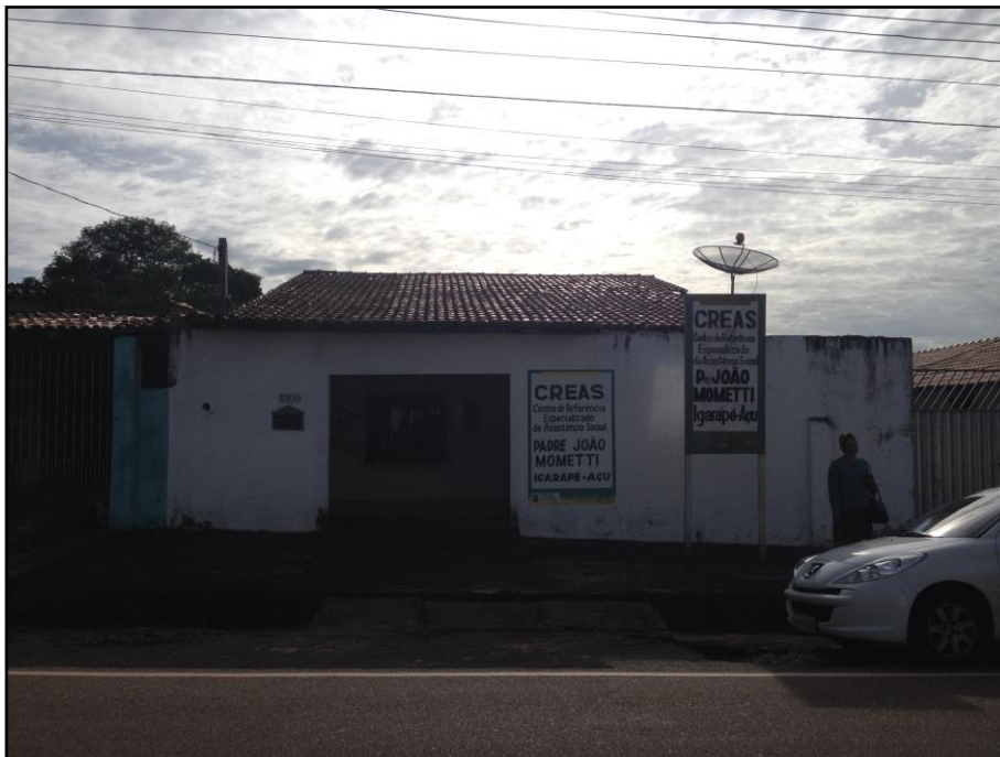
Vista frontal da edificação
