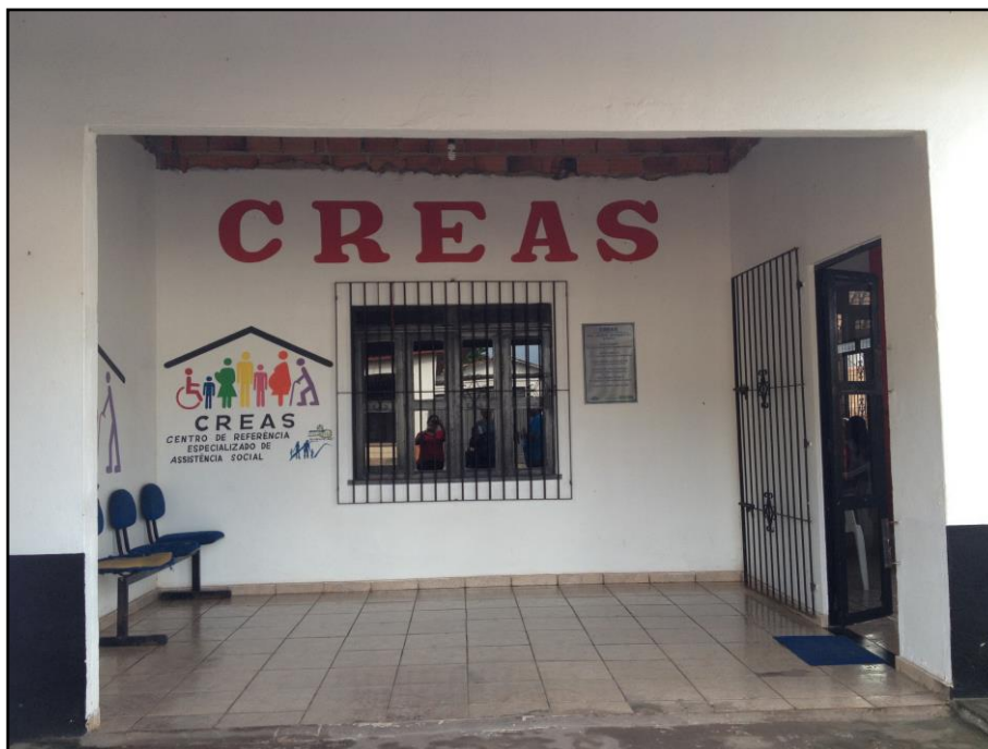
Vista interna hall de entrada da edificação
