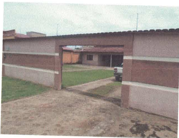
Imagem 01: Faixada Frontal do local;
