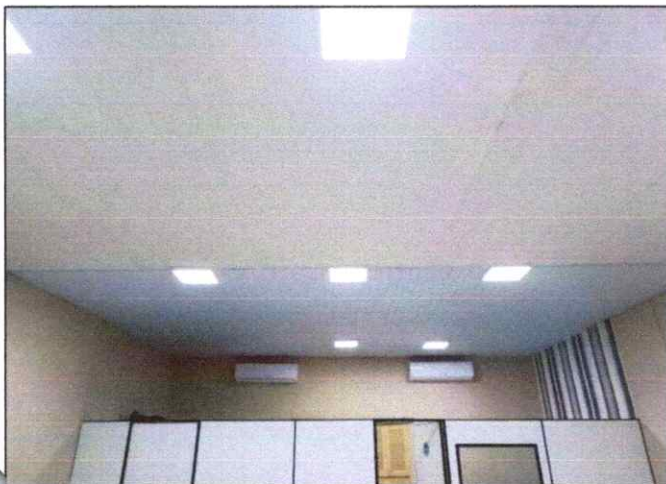
Foto 05: Forro em réguas de PVC (Padrão médio). Fonte: SEPLANO
