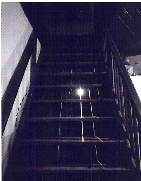
FIGURA 5— ESCADA EM MADEIRA
