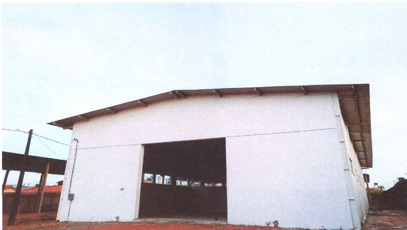
Figura 1, Vista – Frontal. Galpão com pintura acrílica ( duas demãos ), porta metálica , cobertura metálica . Pilares, terças e vigas pré-moldadas. Frente 15 m , pé direito +- 7 m . Piso em korodur.
