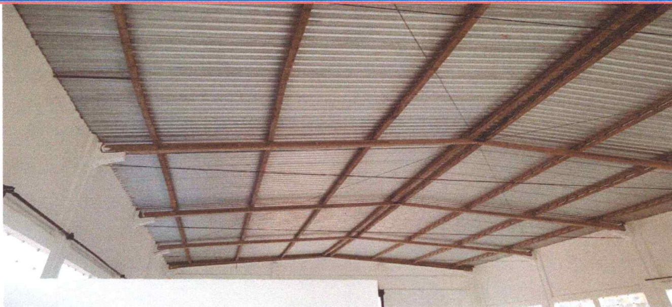
Figura 3, Cobertura – telhas metálicas aluzinco , terças e vigas pré-moldadas, consolos pré-moldados.
