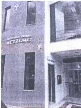
Imagem 1: Entrada do prédio
