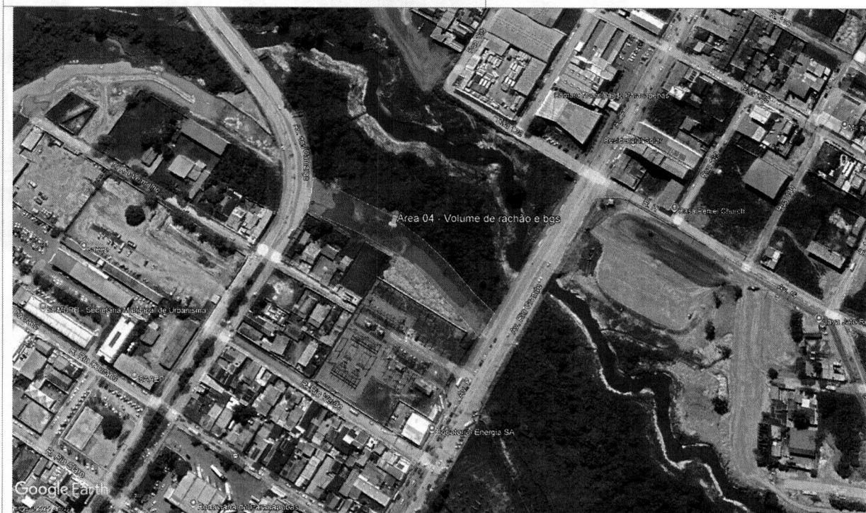
Figura 05 – Área 04 – Área de levantamento do volume de Rachão e BGS
