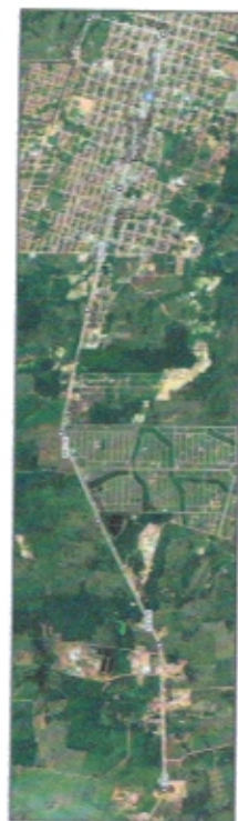
DISTÂNCIA MÉDIA: MOBILIZAÇÃO DE EQUIPAMENTOS E TRANSPORTE DE CBUQ= 18KM
