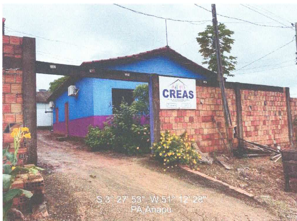
Imagem 03 - MURO E PORTÃO DE ENTRADA
