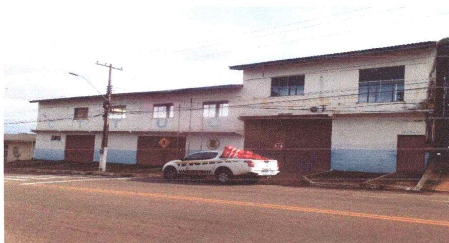
Figura 7 - Fachada do prédio
