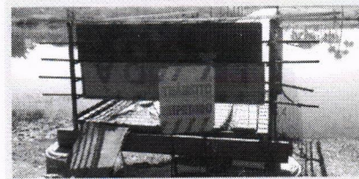
Ponte reconstruída no lago, ainda não foi concluída
