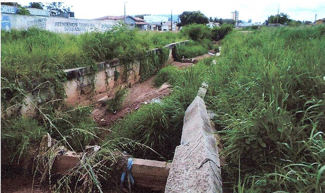
Figura 06 – Estrutura danificada, ocorrendo colapso devido os desmoronamentos do local. Estrutura nesse trecho não possui continuação e assim não possui os travamentos necessários.
