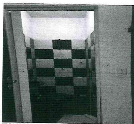
FONTE: SEMEC-DIEC-COEI-2022 06- BANHEIRO
