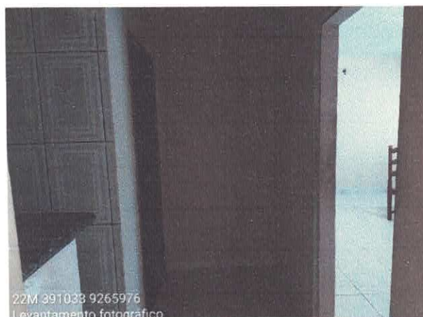
Figura 8 - Hall de acesso
