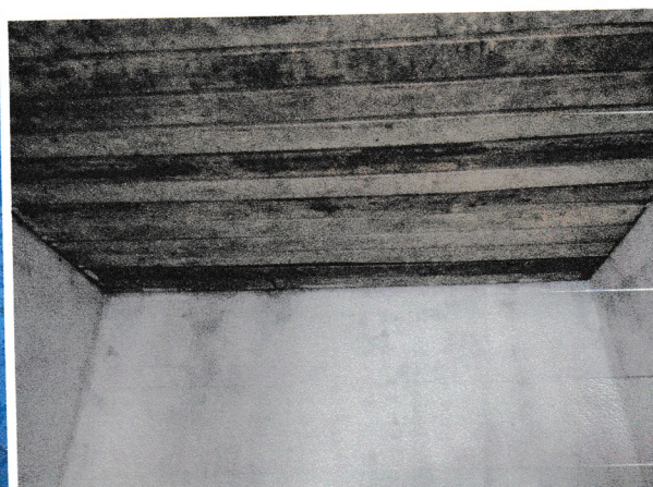
FOTOS 7 e 8: Parede com infiltração e depósito de merenda sem forro
