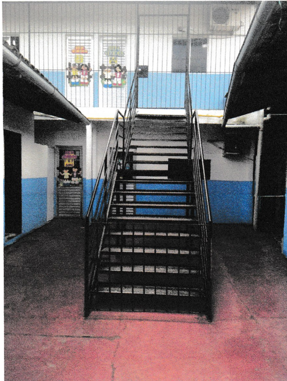
FOTO 1: Escada em estrutura metálica
