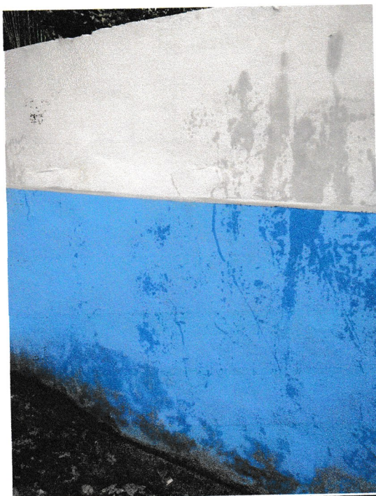
FOTOS 7 e 8: Parede com infiltração e depósito de merenda sem forro
