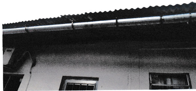
FOTOS 2,3 e 4: Cobertura do prédio
