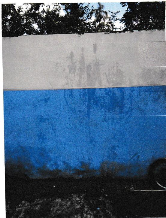
FOTOS 5 e 6: Sala sem forro e parede do muro com pontos de infiltração
