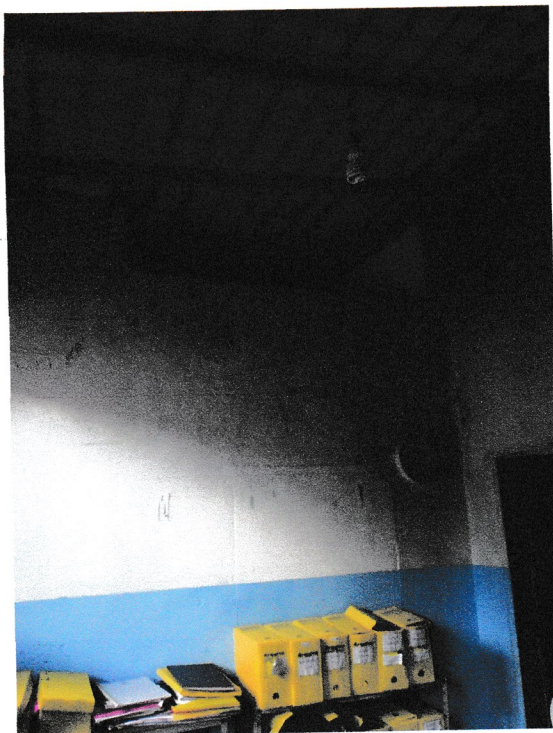
FOTOS 5 e 6: Sala sem forro e parede do muro com pontos de infiltração
