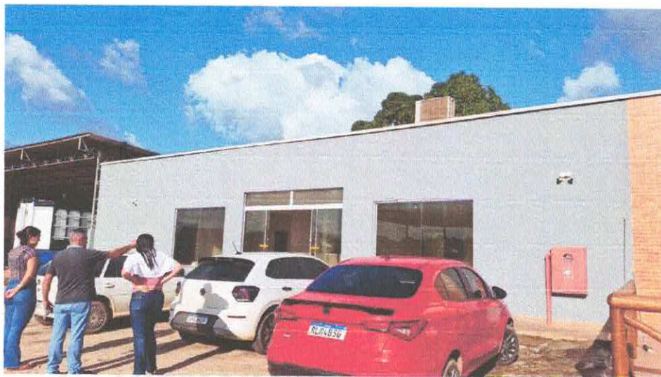
Foto 03: Fachada frontal vista 2.
