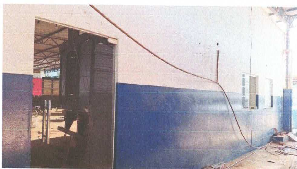
Foto 02: Fachada lateral da edificação.
