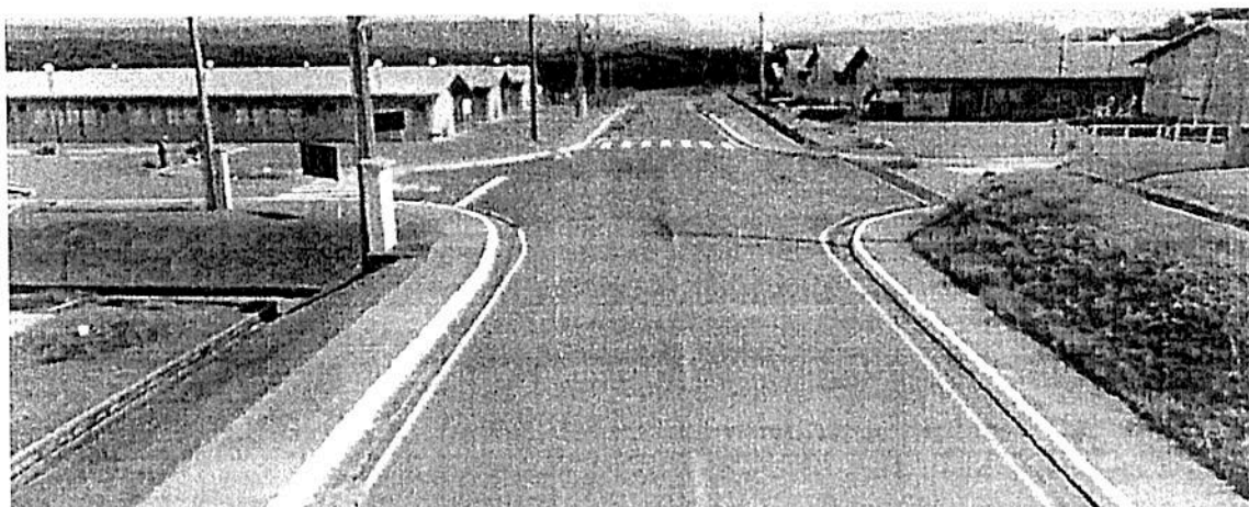
Figura: 14 - Visão das calçadas e faixas de pedestres.
