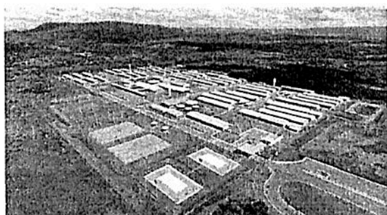
Figura: 7 - Estrutura Poliesportiva do Polo Educacional
