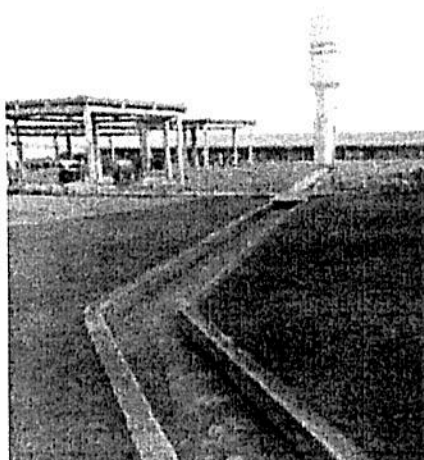
Reservatórios Tipo Torre
