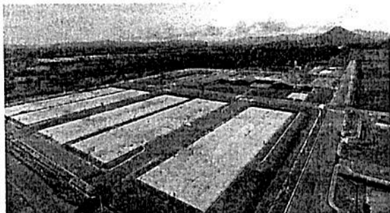
Figura: 5 - Quadras com de piso de concreto prontos
