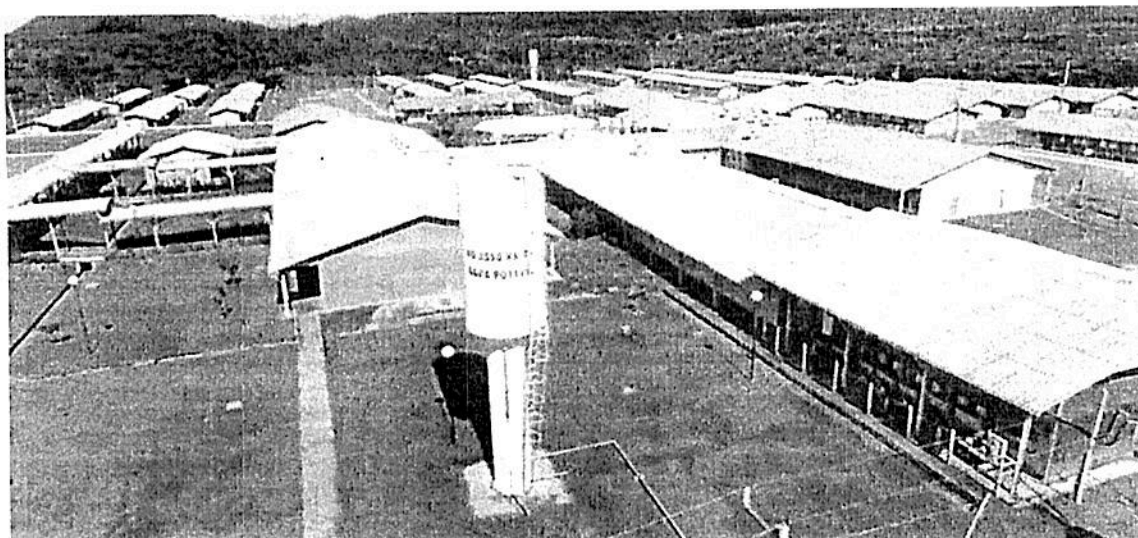
Figura: 29 - Visão Ampliada Reservatório Pólo Educacional
