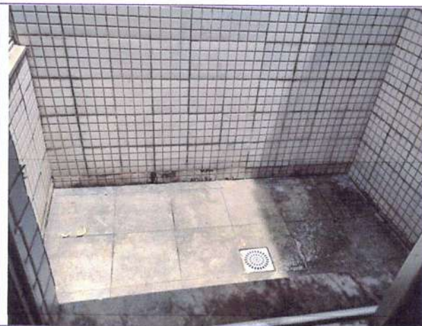
Foto 23: Área de ventilação 02
