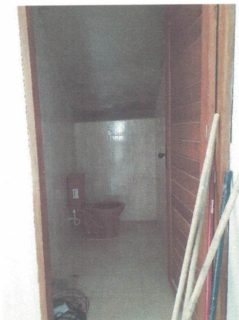
FIGURA 03: Lavabo sob escada
