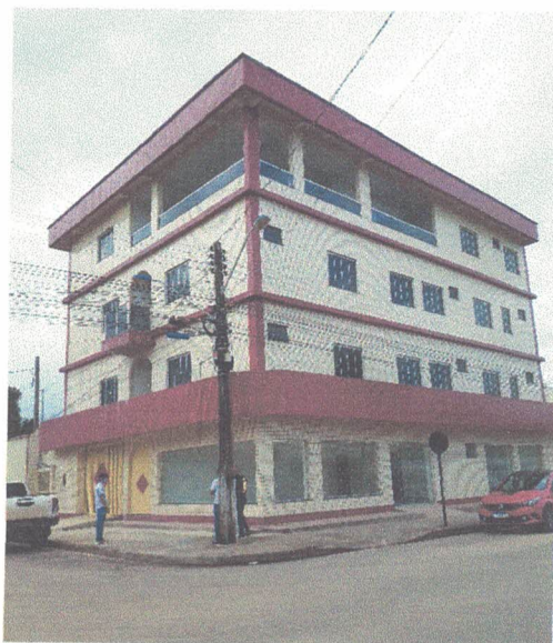
FIGURA 01: Fachada do Prédio
