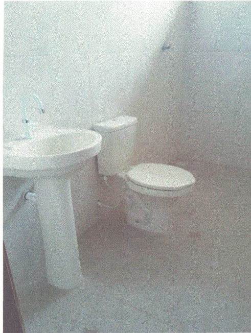
FIGURA 14: Imagem do WC da sala 01 da Cobertura
