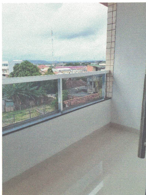
FIGURA 13: Imagem varanda da Sala 01 da Cobertura
