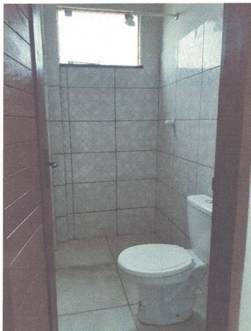
FIGURA 10: Imagem do WC do apartamento tipo – 1º Pavimento
