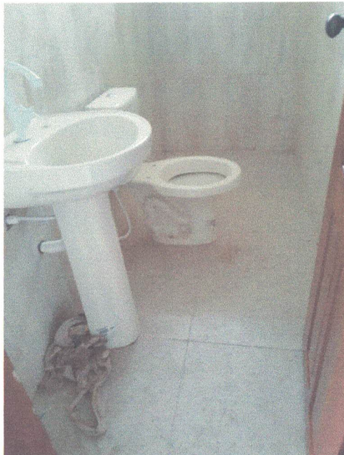
FIGURA 15: Imagem do banheiro social Cobertura
