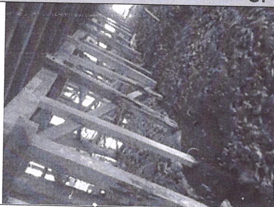
Ponte de acesso à escola com a estrutura de madeira deteriorada, com risco iminente de desabamento.
