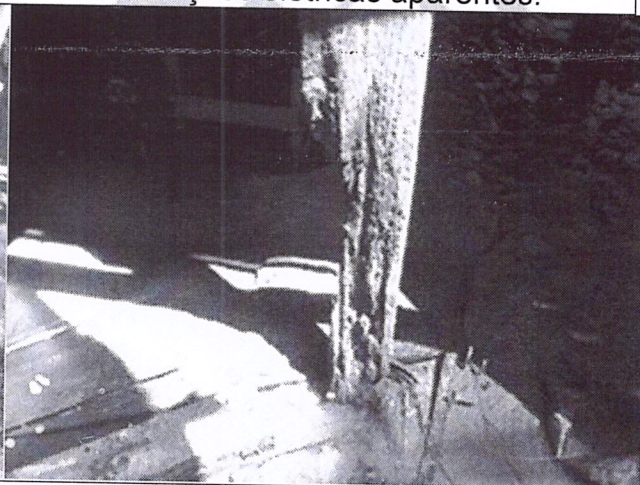
Esteios de sustentação da escola em grave estado de deterioração.
