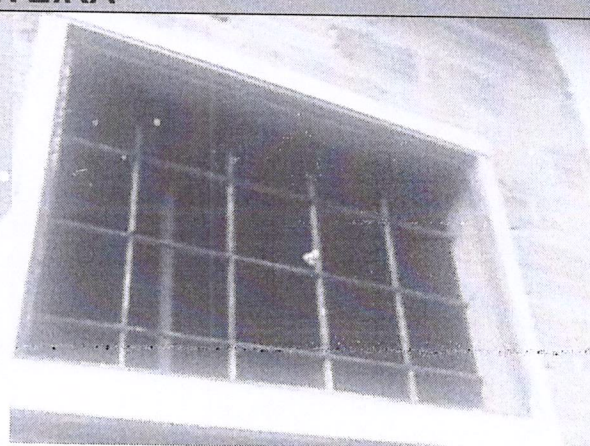
Parede externa não revestida e vão sem janela.
