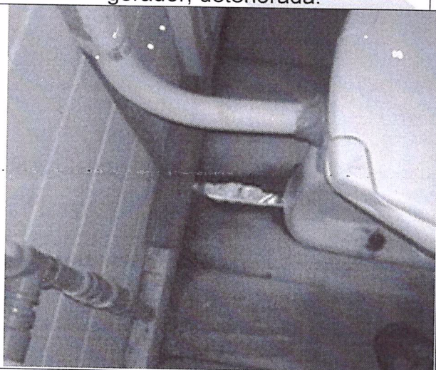
Assoalho de madeira deteriorado e instalações de água e esgoto inadequadas.
