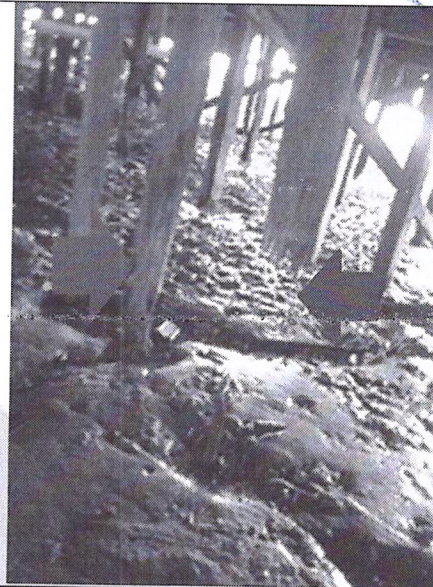
Estrutura de sustentação da escola bastante deteriorada com risco de recalque e desabamento.
