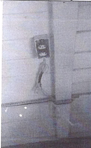
Instalações elétricas expostas e danificadas.
