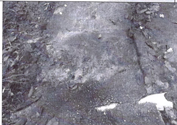
Pavimentação do passeio interno danificado, acessibilidade prejudicada.
