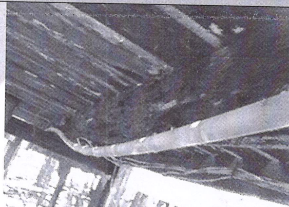
Ponte de acesso à escola com a estrutura de madeira deteriorada, com risco iminente de desabamento.
