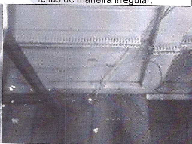
Fiação elétrica exposta.
