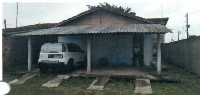
VISTA DOS FUNDOS
