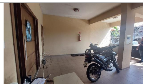
Foto 2: pátio garagem coberta.
