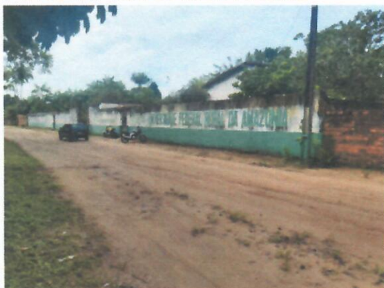
FOTO-01: MURO DA FRENTE
