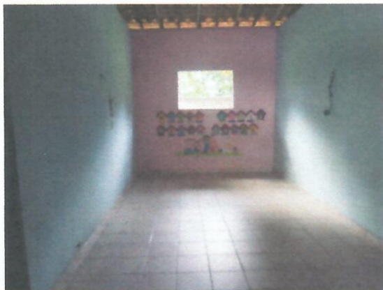
FOTO-07: SALA DE AULA
