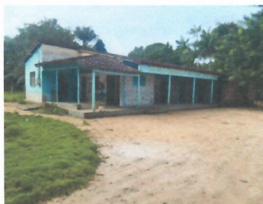
FOTO-04: BLOCO DA CRECHE
