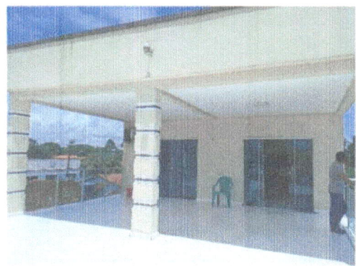
Foto 01: Vista da fachada principal.
