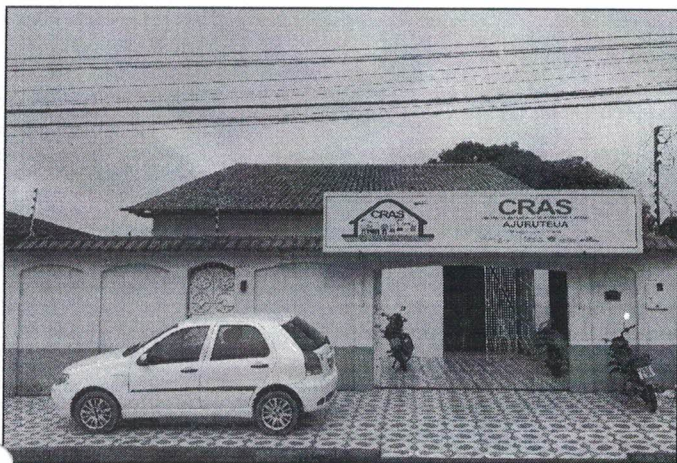
Foto 01: Fachada Principal (Rua Sinhá Ferreira) Fonte: SEPLAN
