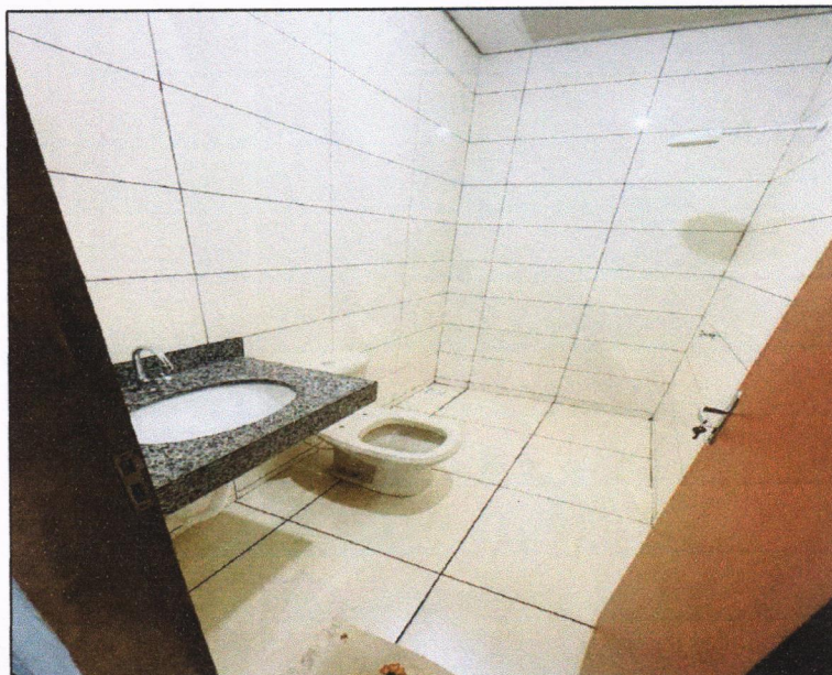
Figura 4 - Vista do banheiro
