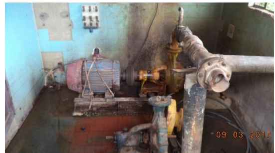
Vista Parcial do Barrilete Sucção e Recalque e Conjunto Moto-Bomba WEG 200M – 40CV
