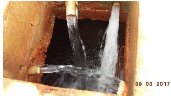
Chegada de Água dos PTP's ao Reservatório Apoiado RAP 227m 3
