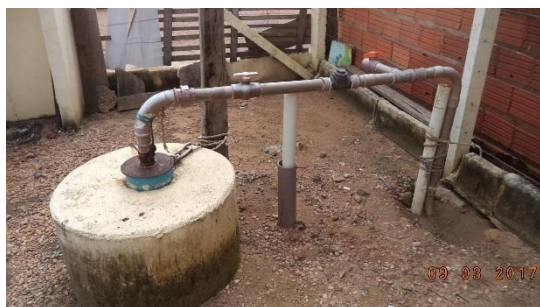
Vista PTP 6" – Prof. 100m – Barrilete PVC 2" – Vazão 9,0m³/h e Painel de Comando
