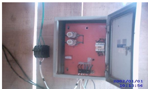
Vista PTP 4” – Prof. 100m – Barrilete 2” – 3,5CV – Vazão 7,5m³/h e Painel de Comando Elétrico
