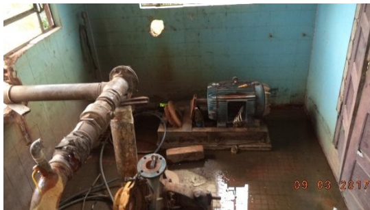
Vista Parcial do Barrilete Sucção e Recalque e Conjunto Moto-Bomba WEG 200M – 40CV
