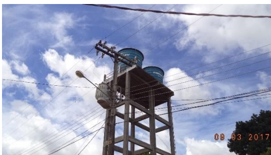
Vista do Reservatório Elevado de Distribuição REL 40m³ (sendo 20m³ cada)
