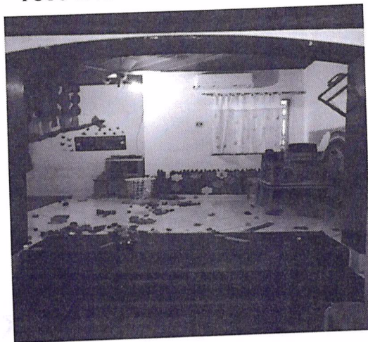
FOTO 08 : SALA DE AULA
