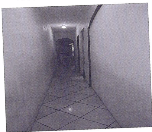
FOTO 09 : ÁREA DE CIRCULAÇÃO
