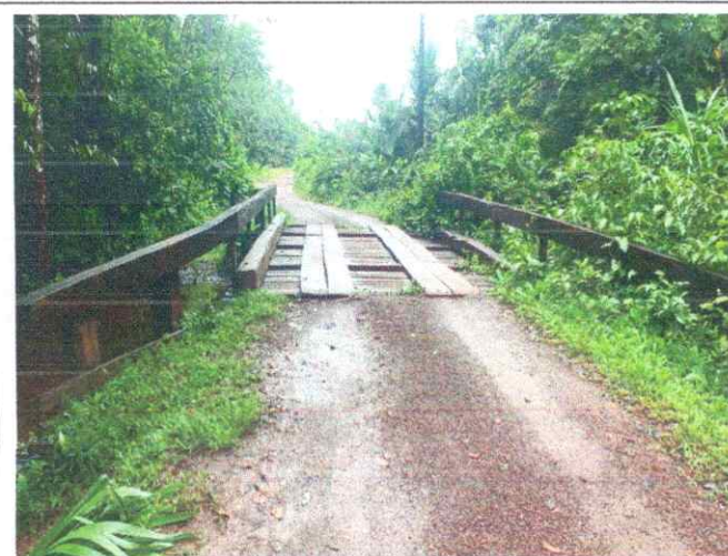
PONTE SOBRE O RIO JORDÃO
