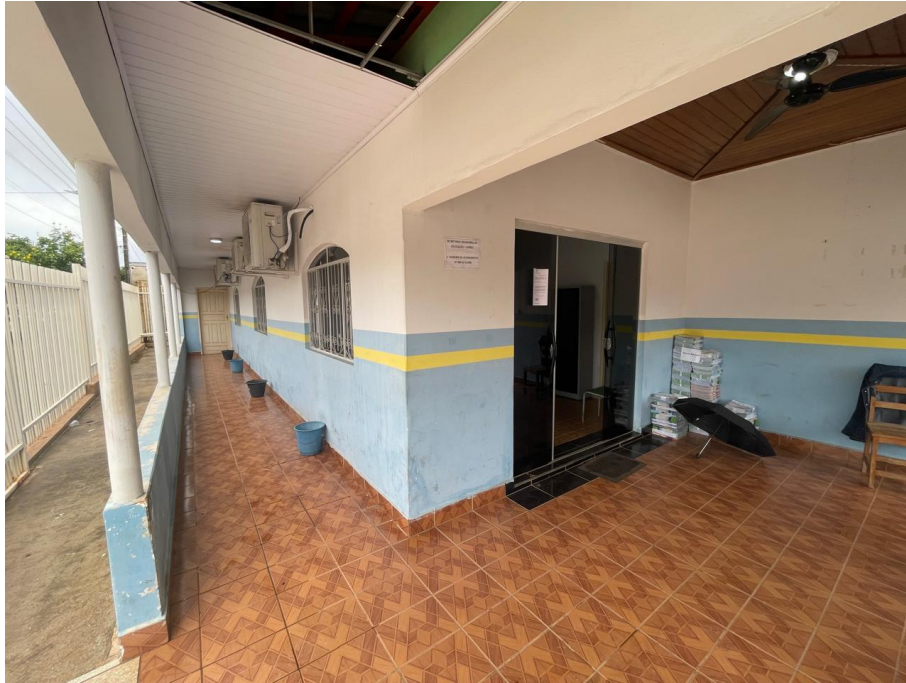
IMAGEM 4: VISTA ANTERIOR DA EDIFICAÇÃO
