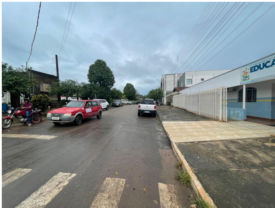
IMAGEM 2: VISTA LATERAL ESQUERDA À EDIFICAÇÃO
