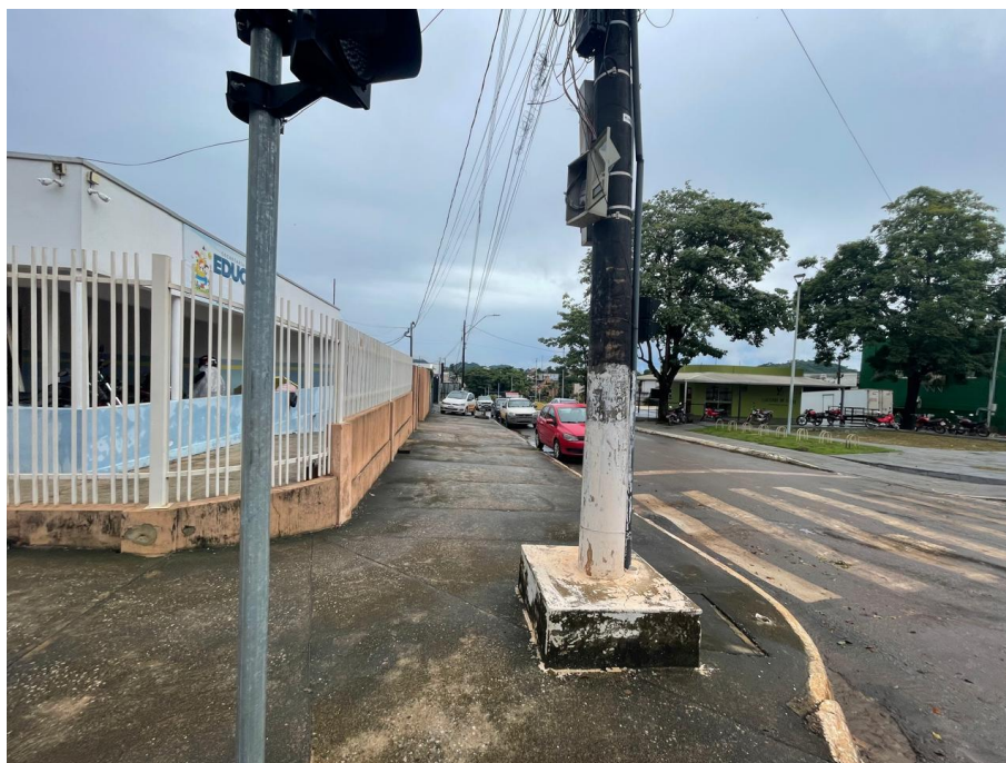
IMAGEM 1: VISTA LATERAL DIREITA À EDIFICAÇÃO
