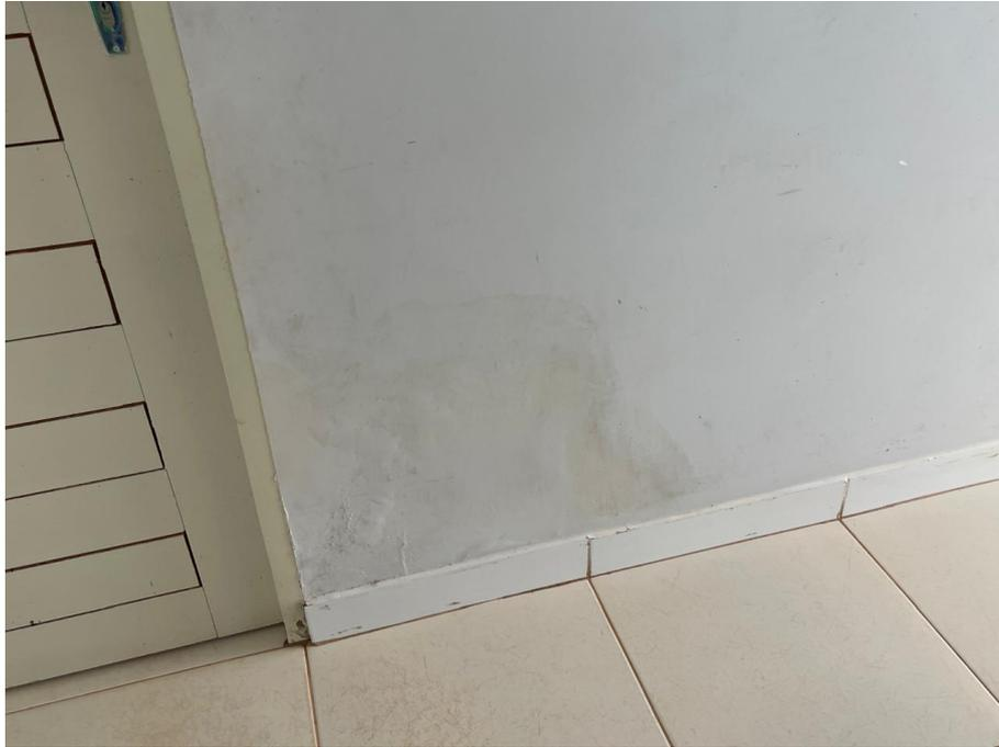
**IMAGEM 15: INDÍCIOS DE UMIDADE ASCENDETE PROVENIENTE DE FALTA DE IMPERMEABILIZAÇÃO DAS FUNDAÇÕES**
