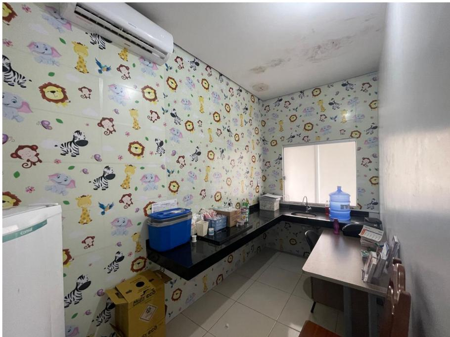
**IMAGEM 8: SALA DE VACINA – NOTA-SE NO FORRO MOFO PROVENIENTE DE VAZAMENTO DA COBERTURA**
