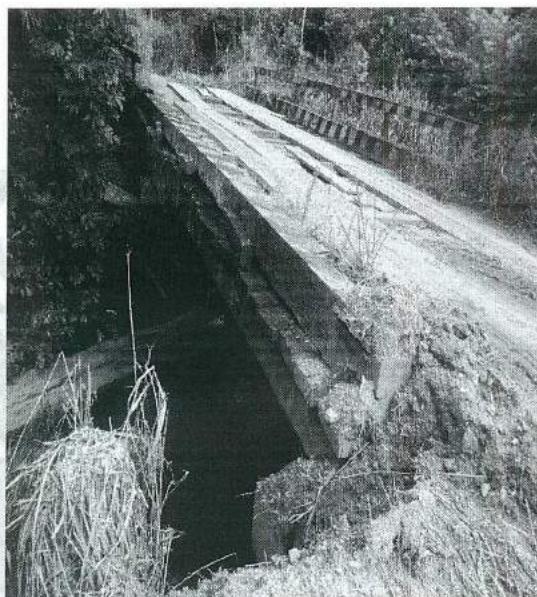
Vista da ponte, com risco devido o desmoronamento de terra arrastado pelo rio.
