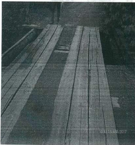
Vista da ponte para recuperação e manutenção.
