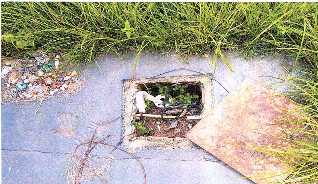
Figura 16 – poço sem uso
