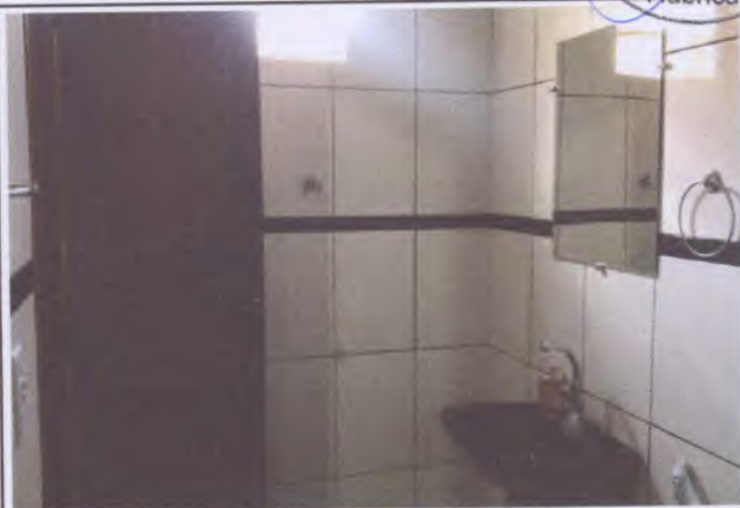
Foto 32: Banheiro localizado no interior da sala 04.
