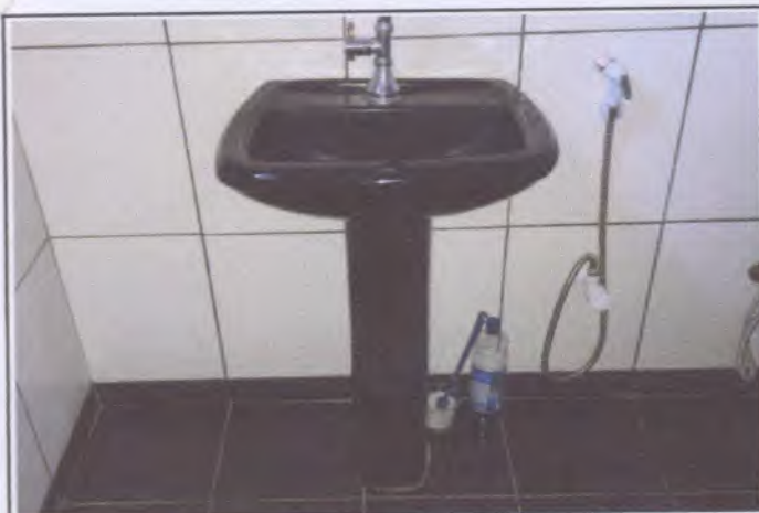
Foto 33: Banheiro localizado no interior da sala 04.
