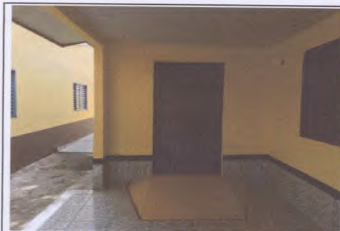
Foto 07: Rampagem acessível que permite o acesso de cadeirantes ao interior da recepção.
