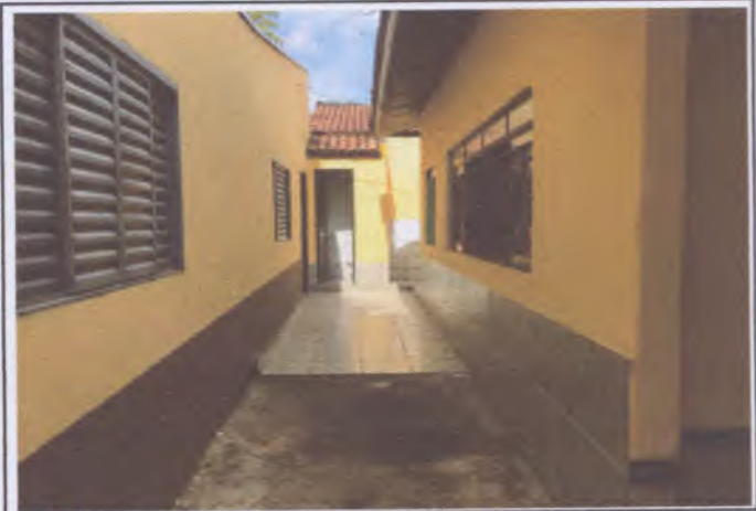
Foto 48: Corredor que permite acesso aos fundos do imóvel.
