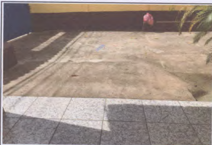
Foto 06: Rampa acessível que permite o acesso de cadeirantes ao interior do imóvel.
