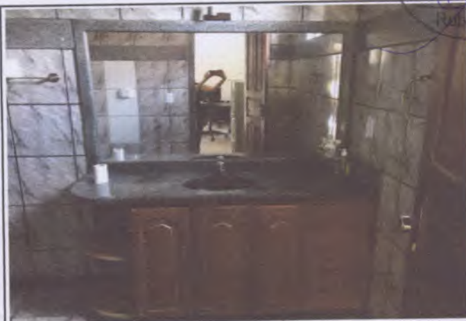
Foto 38: Banheiro localizado no interior da sala 05.
