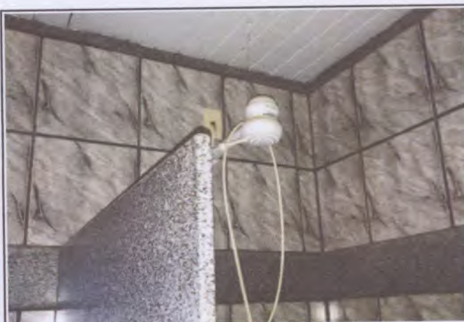
Foto 40: Banheiro localizado no interior da sala 05.
