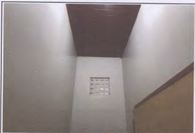
Foto 24: Cobogó que permite a circulação de ar no interior do depósito 01.
