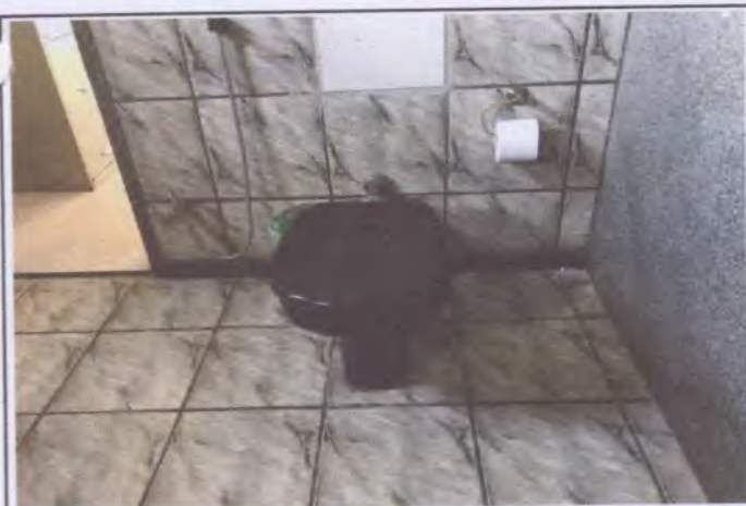
Foto 39: Banheiro localizado no interior da sala 05.
