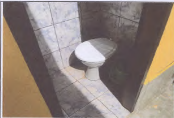
Foto 49: Banheiro localizado nos fundos do imóvel.
