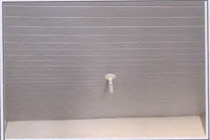
Foto 46: Forro PVC instalado no auditório.
