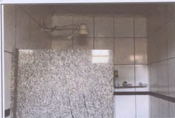
Foto 35: Banheiro localizado no interior da sala 04.
