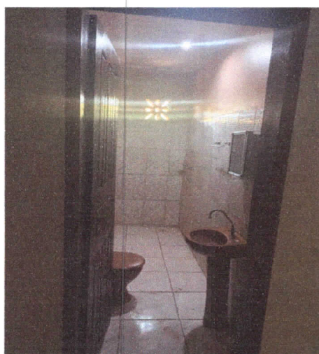
Foto 07: vista frontal banheiro 03
