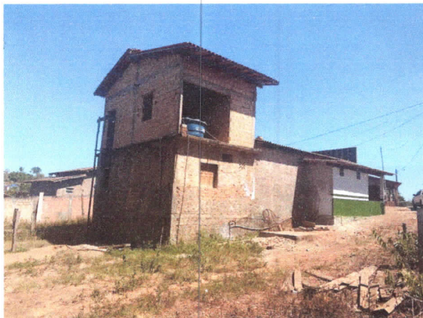
Foto 01: vista fundo/LATERAL ESQ.
