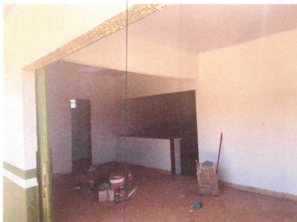
Foto 05: Sala de recepção sala 01
