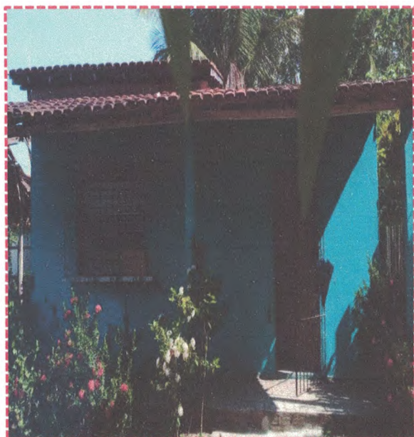
Foto 01: Fachada principal do imóvel
