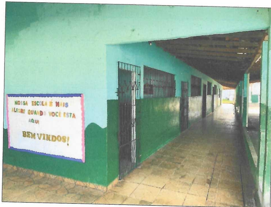
Vista interna pátio de entrada da edificação
