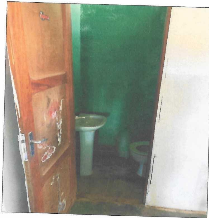
Vista banheiro sala 02
