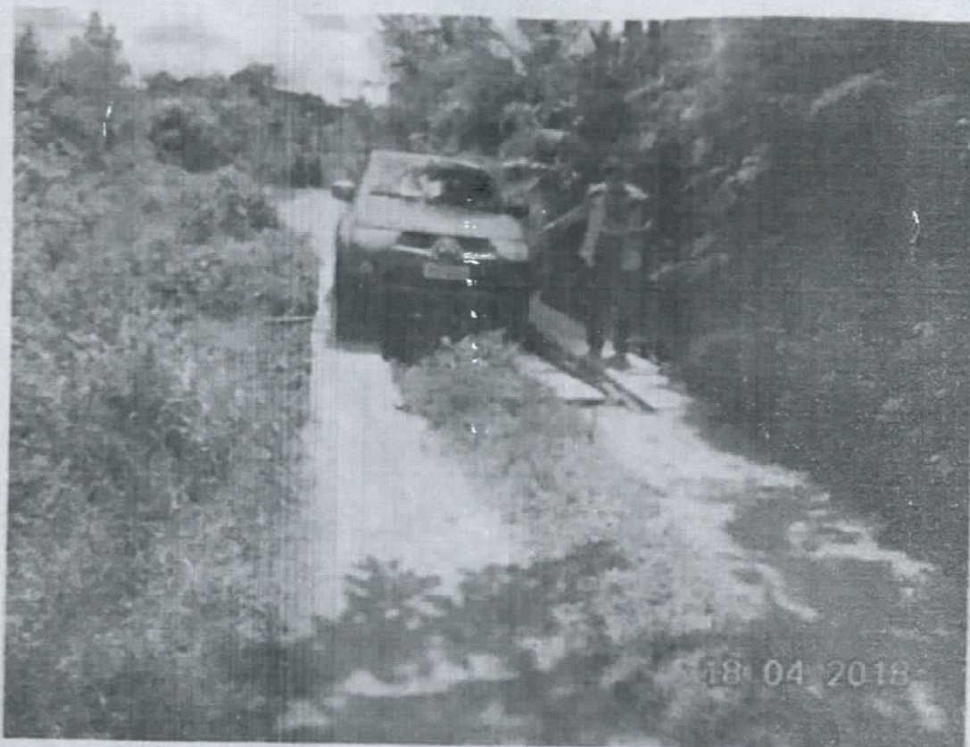
Ponte da Serrinha GPS (S1°53'45.2" W55°20'18.3") – Foto 11
