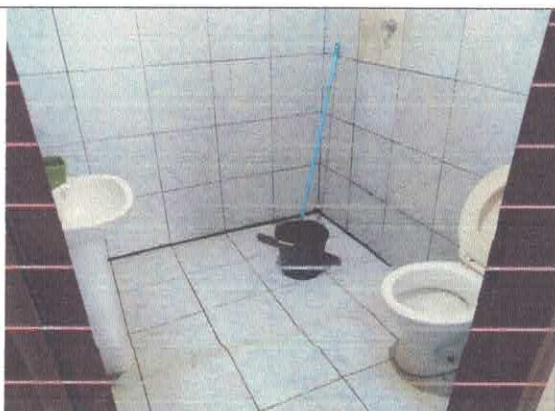
Figura 5 - Vista Interna - Banheiro. Há apenas um banheiro na casa, com piso e paredes revestida de cerâmica, um pouco encardido.
