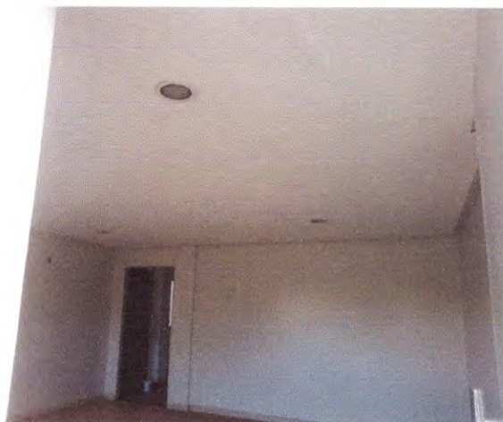
Sala: portas de vidros teto de gesso.
