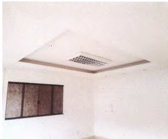
Sala: de Janta portas e janela de Vidros, teto de gesso.
