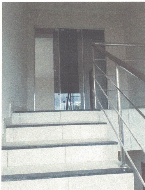
FIGURA 11: Imagem da escada acesso para a Cobertura
