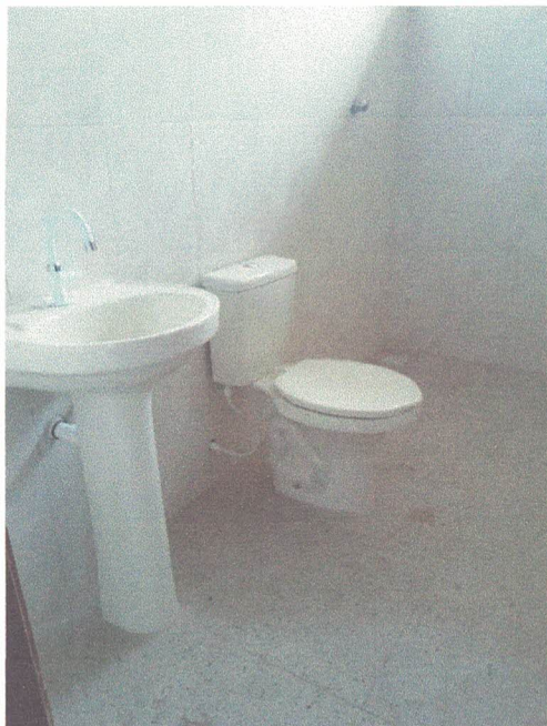
FIGURA 14: Imagem do WC da sala 01 da Cobertura
