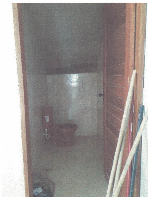
FIGURA 07: Imagem do Lavabo sob a escada no térreo.
