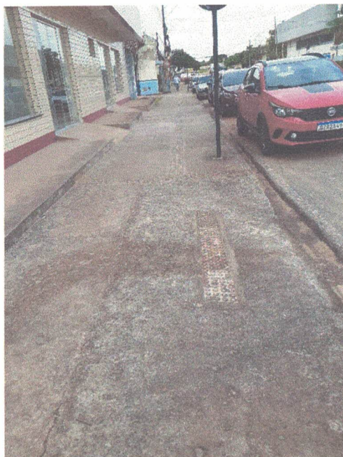
FIGURA 05: Imagem da Calçada da parte frontal do imóvel.
