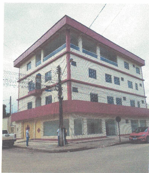
FIGURA 01: Fachada do Prédio
