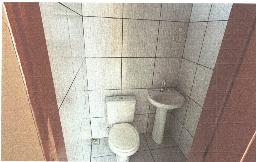
Fotos 04, 05 e 06: Áreas internas e banheiro
