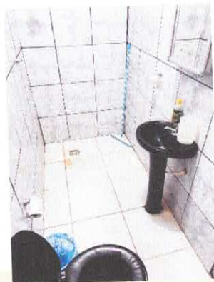
Imagem 06: Banheiro do Imóvel
