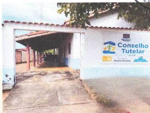
Imagem 02: Fachada do Imóvel
