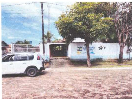
Imagem 01: Fachada do Imóvel
