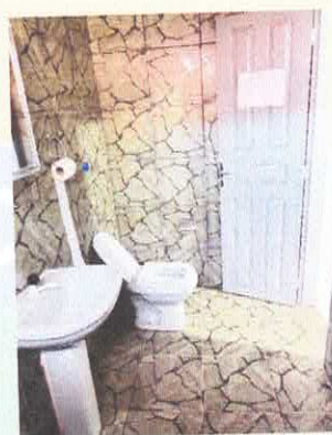
Imagem 08: Banheiro do Imóvel
