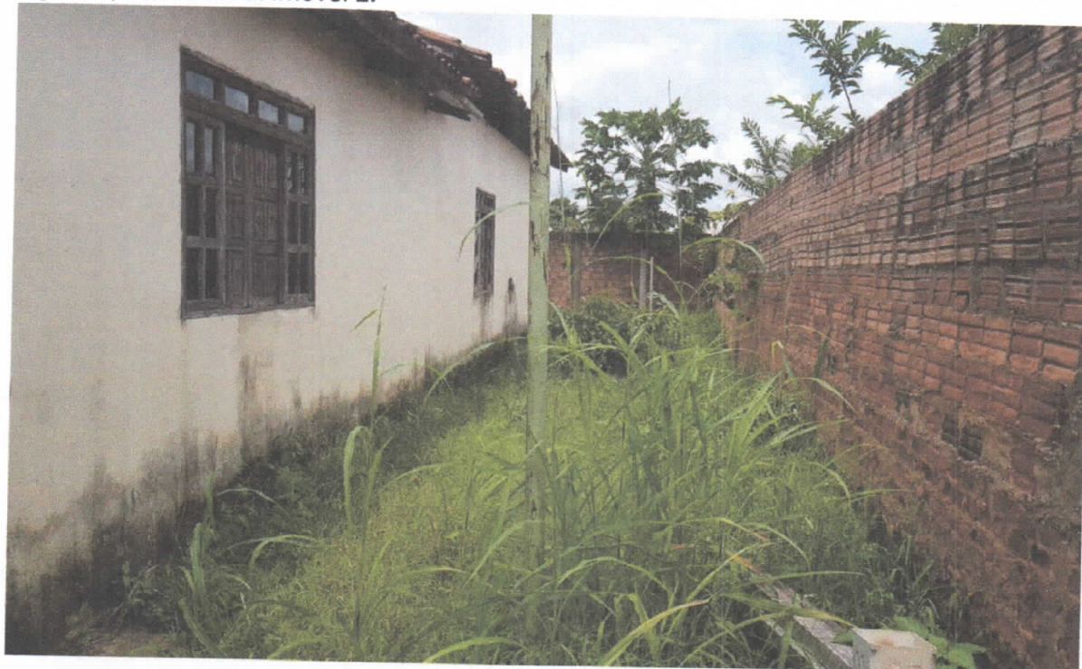
Figura 9, vista lateral imóvel 2.
