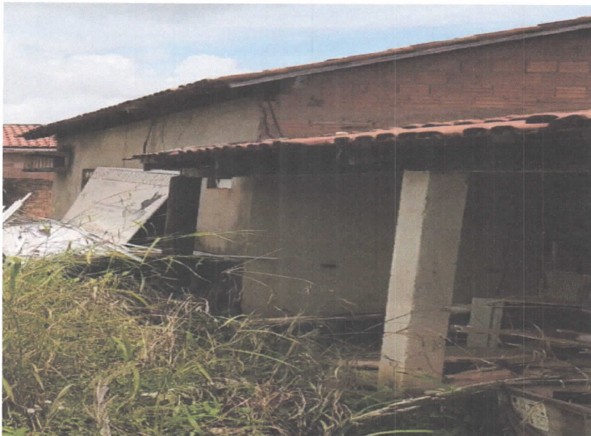
Figura 8, Vista lateral do imóvel 2.
