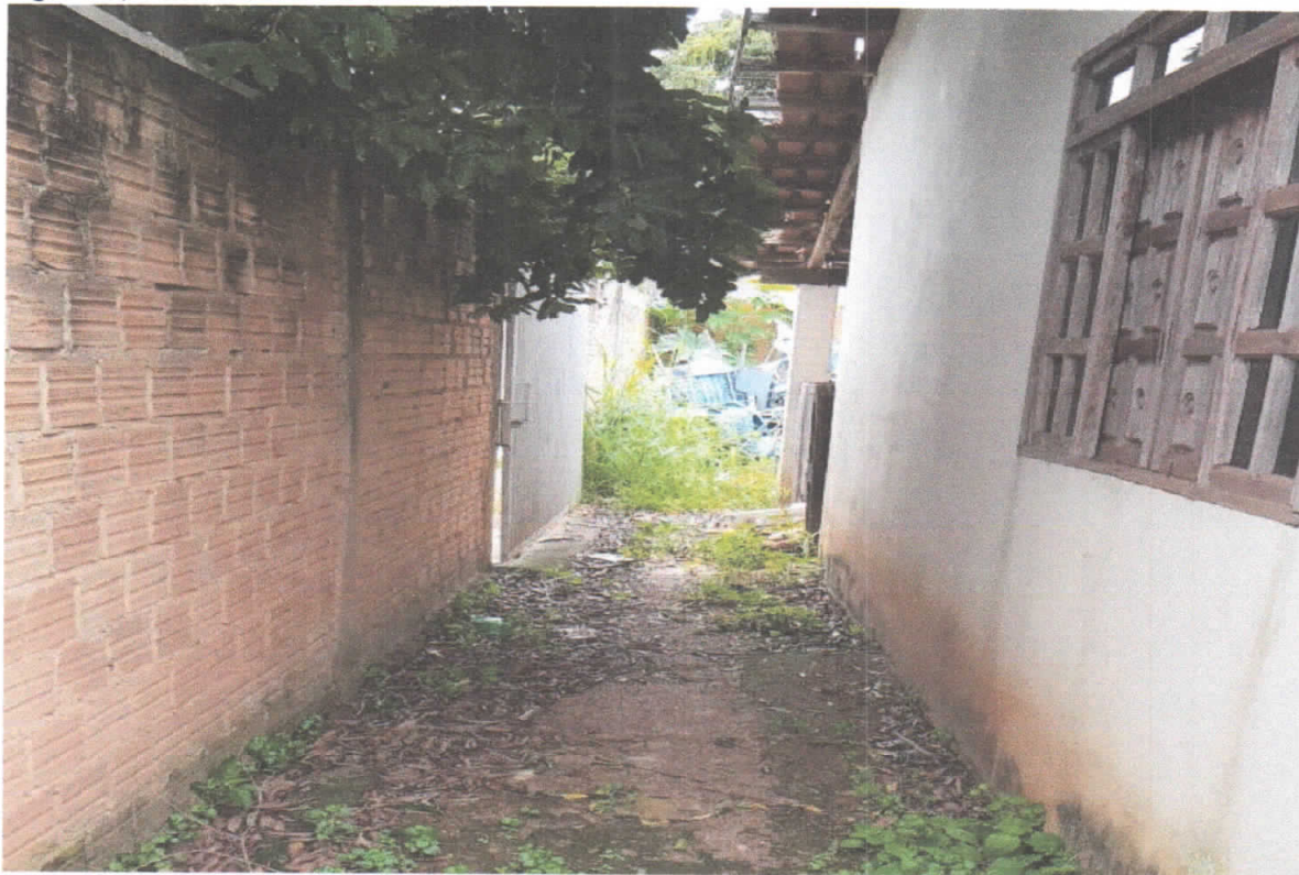
Figura 7, Vista lateral do imóvel 2.
