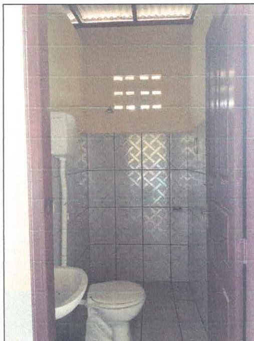
Vista interna banheiros.
