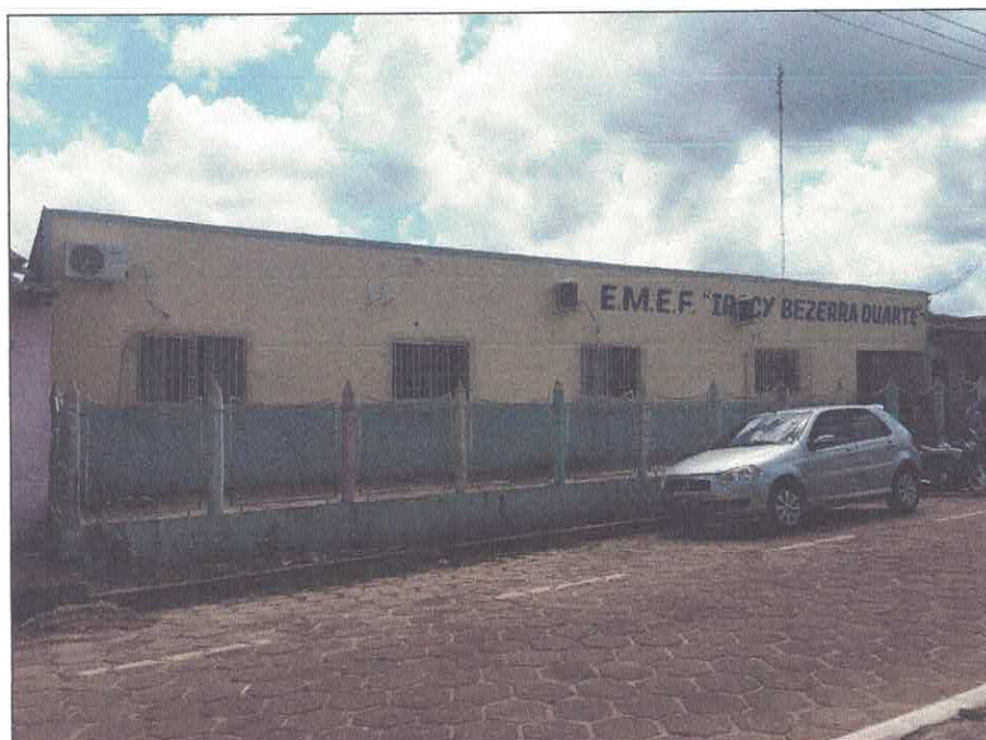
Vista fachada frontal.
