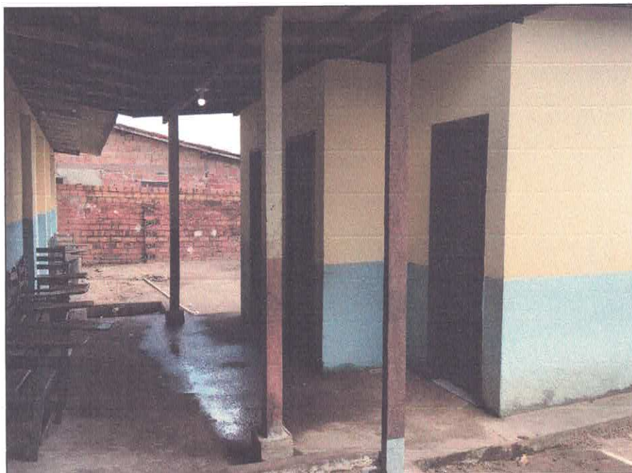
Vista externa área de banheiros.
