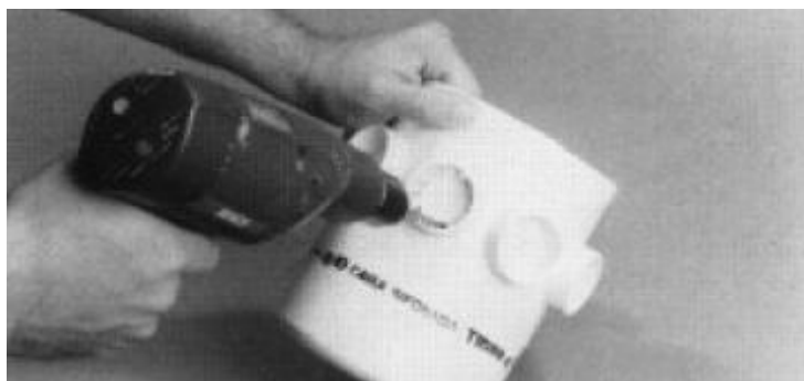
Abertura dos furos nas caixas sifonadas.
