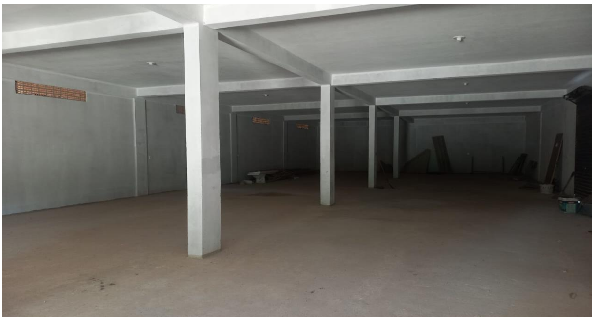
Vista interna do pavimento térreo do imóvel avaliando
