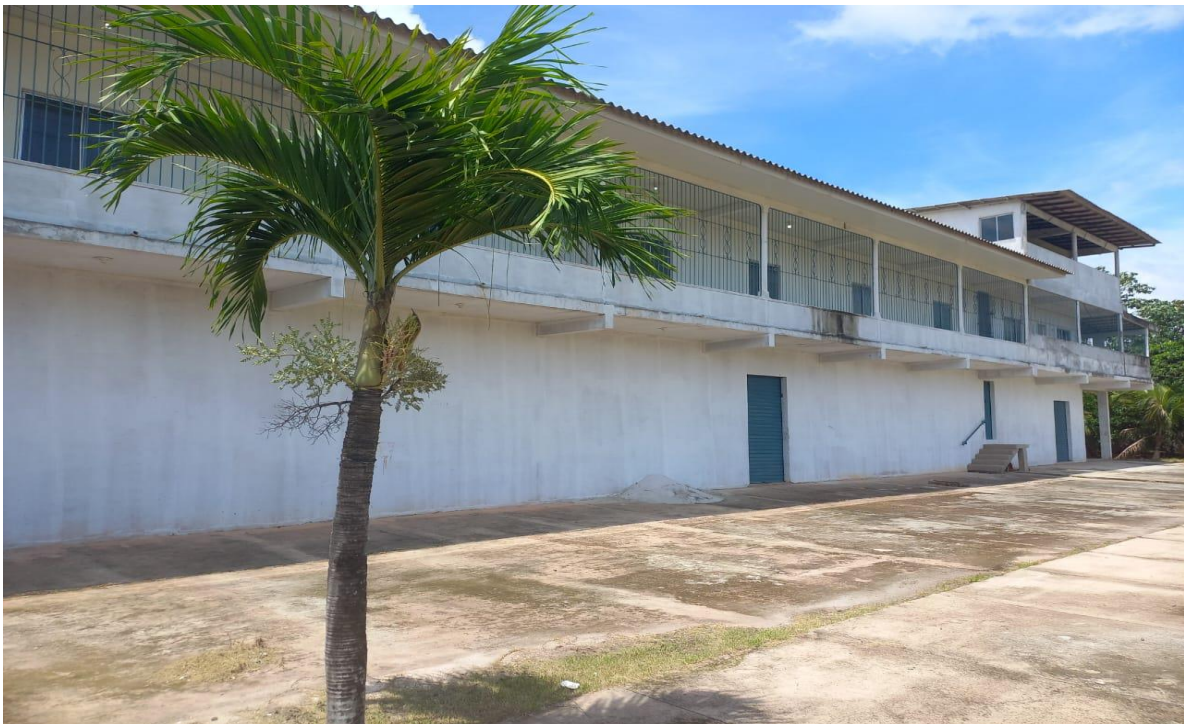
Vista da lateral do imóvel avaliando
