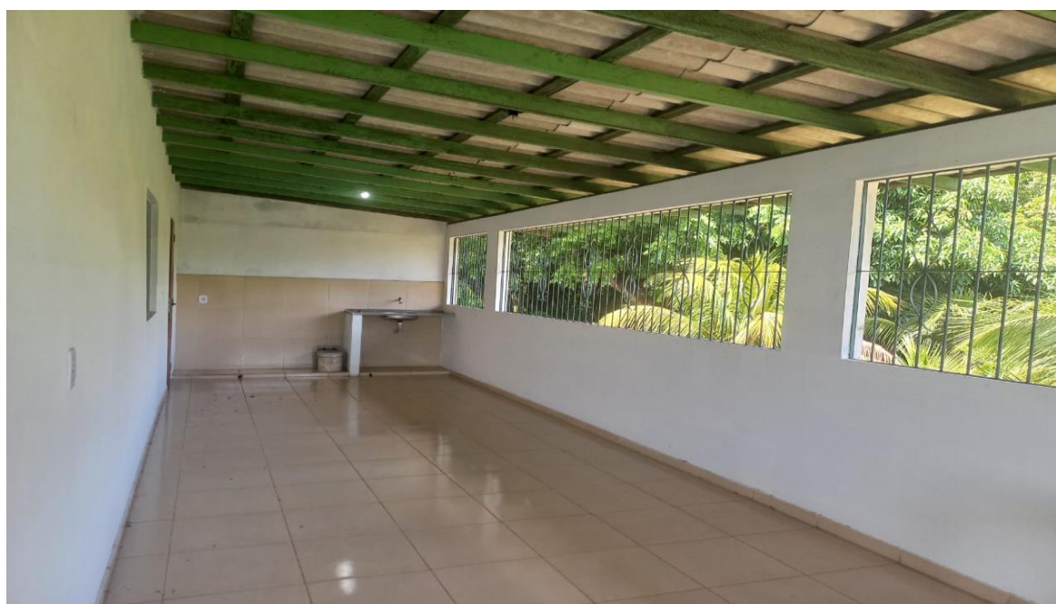
Vista interna do imóvel avaliando
