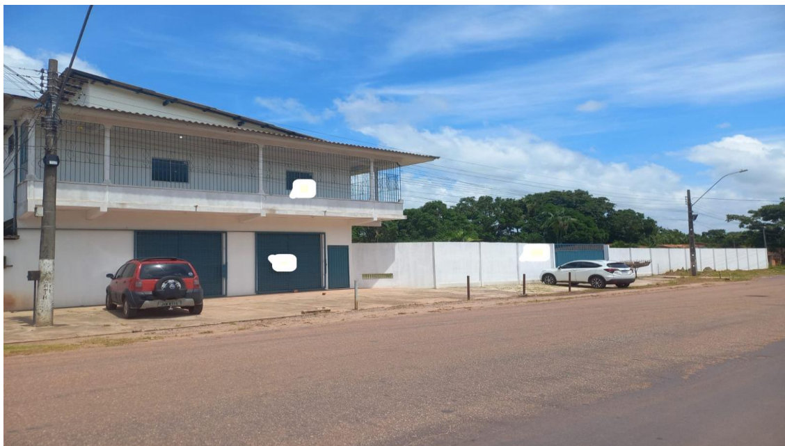
Vista da frente do Imóvel Avaliando
