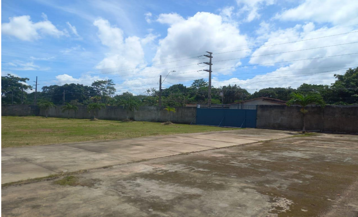
Vista interna do terreno do imóvel avaliando
