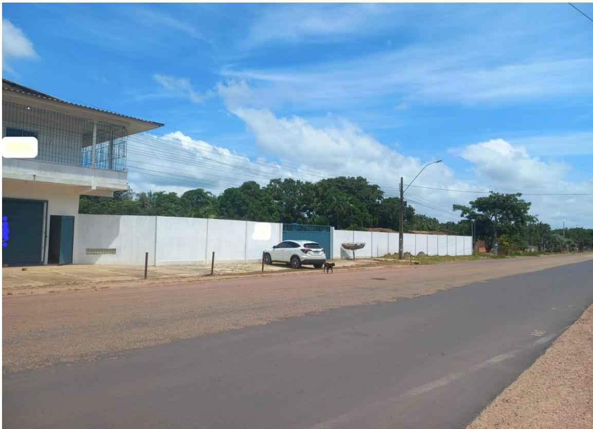
Vista da frente do imóvel avaliando
