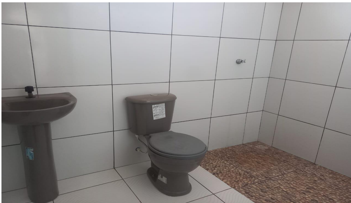
Vista dos banheiros do imóvel avaliando
