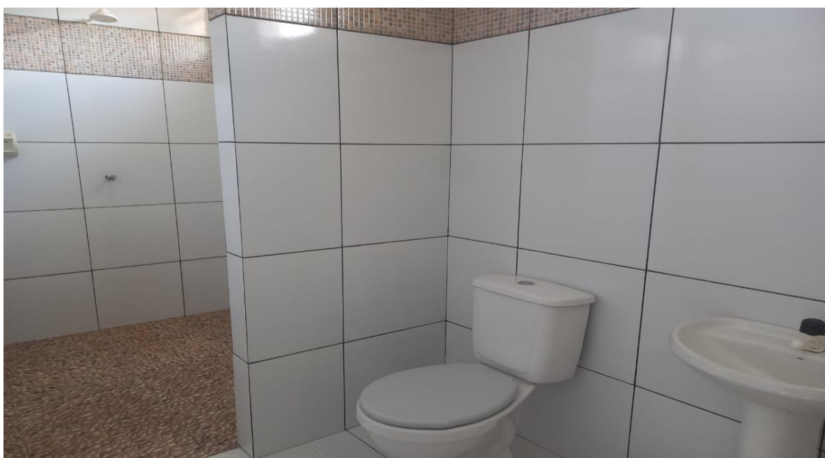
Vista dos banheiros do imóvel avaliando
