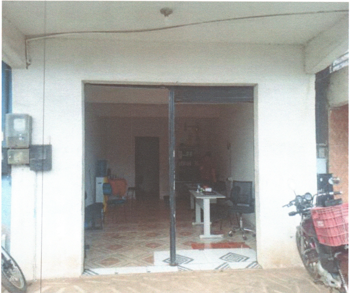
IMAGEM 01: Vista frontal do imóvel
